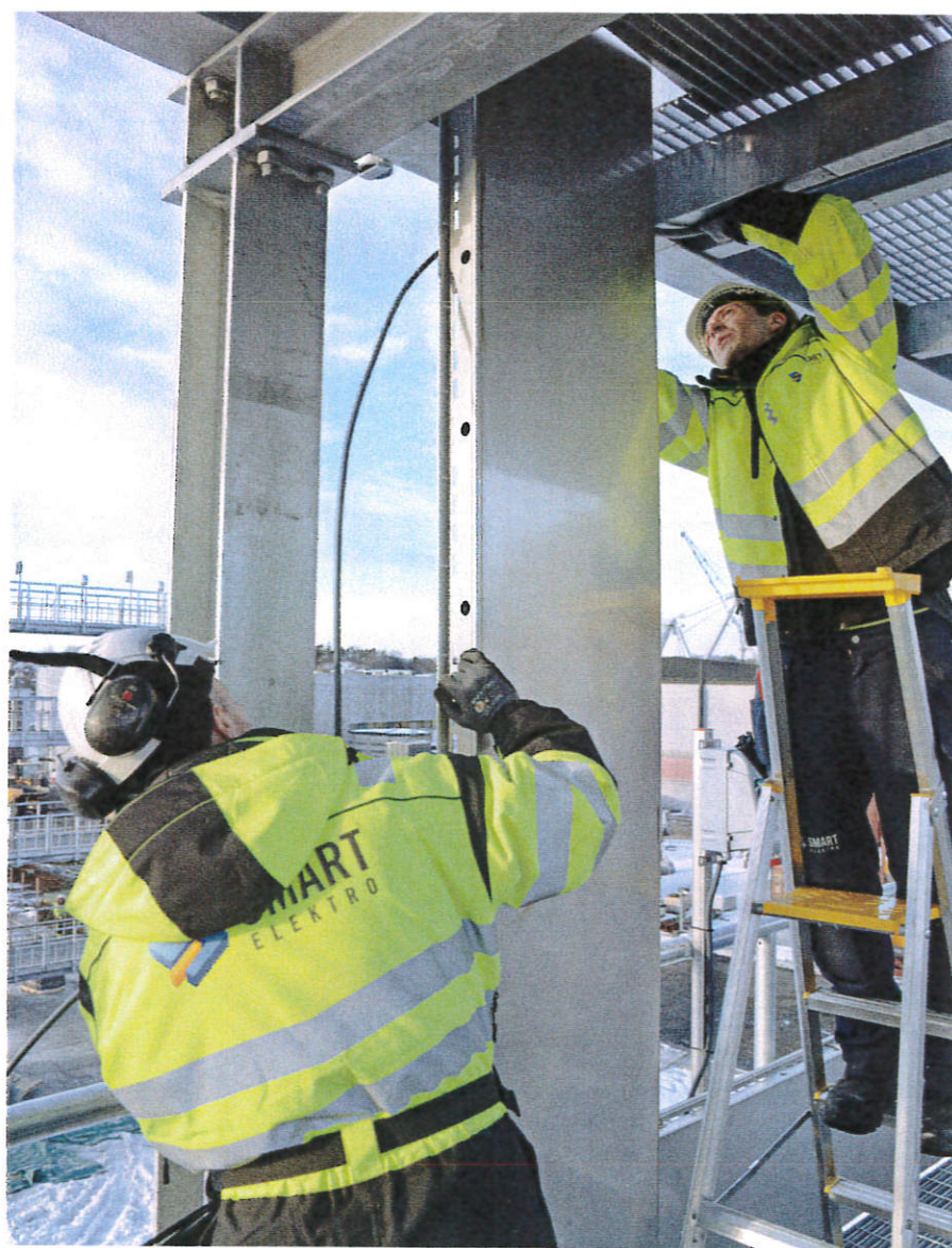
LVS. Ingi Hauksson (t.v.) og Simon Audunsson monterer lysanlegg i et reefer-stack
